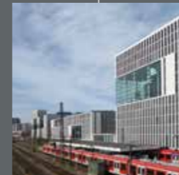
Arnulfpark Früher Containerbahnhof, seit 2005 Wohnquartier und Hightech-Standort mit etwa 5.000 Jobs.
